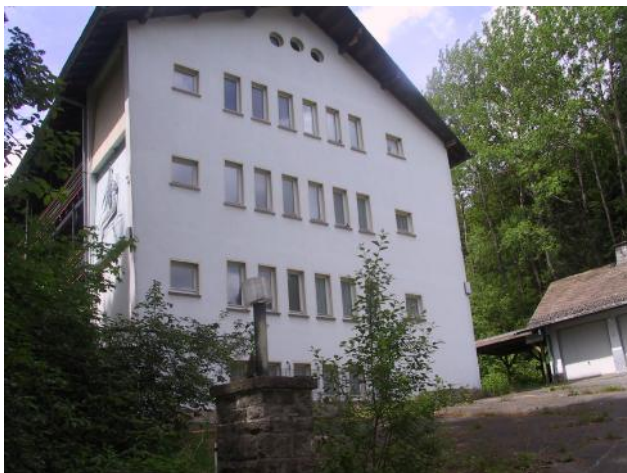
Zijgevel van het 'slaapgebouw'
